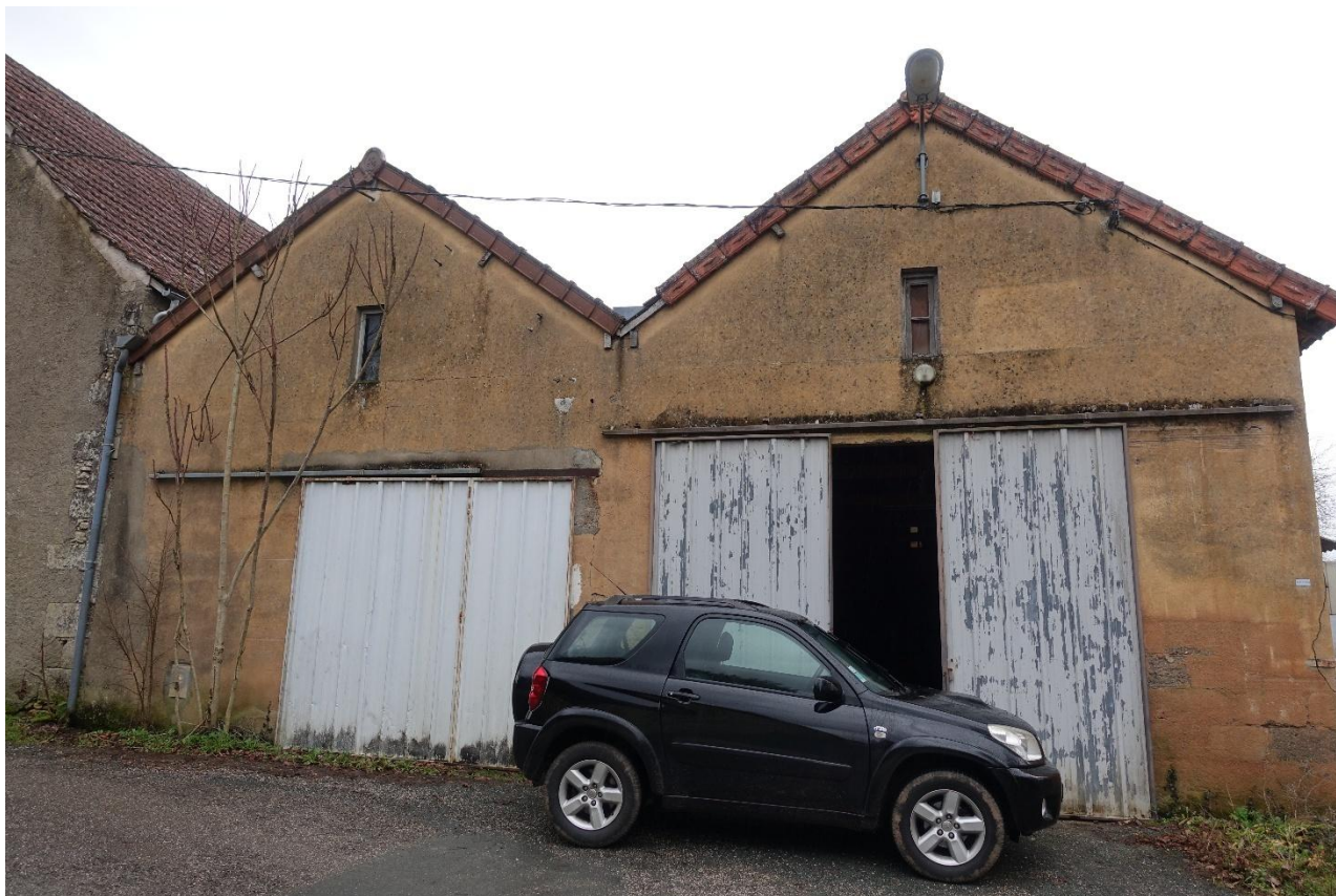
Façade principale du bâtiment (Nord Ouest)
