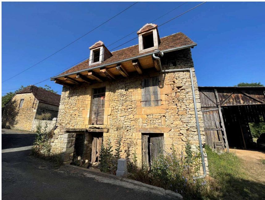
Façade principale est
